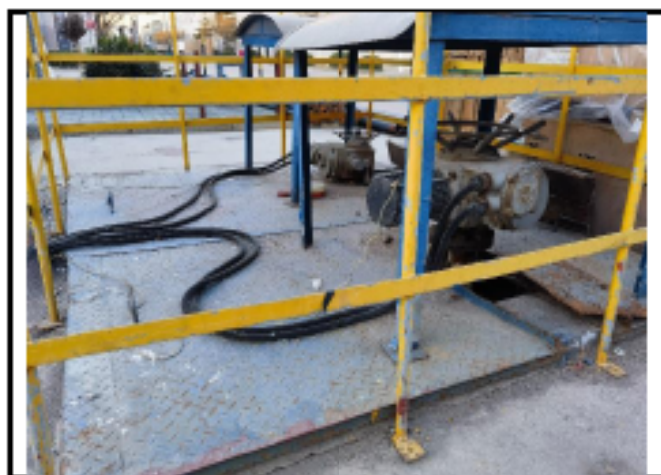
雨水总排口切断措施
